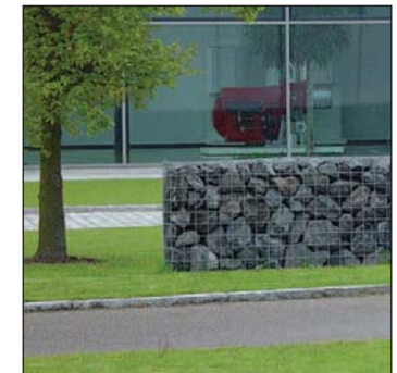
Eksempel på gabion
